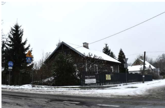
Zabudowa zagrodowa w Krakowianach
