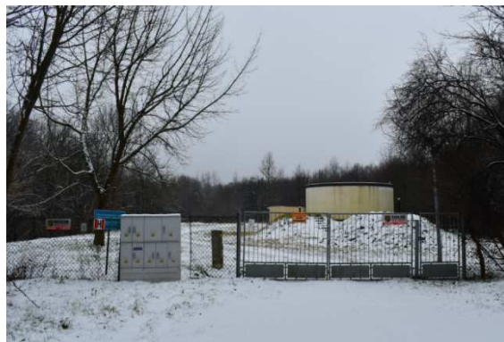
Ujęcie wody w Bielinach
