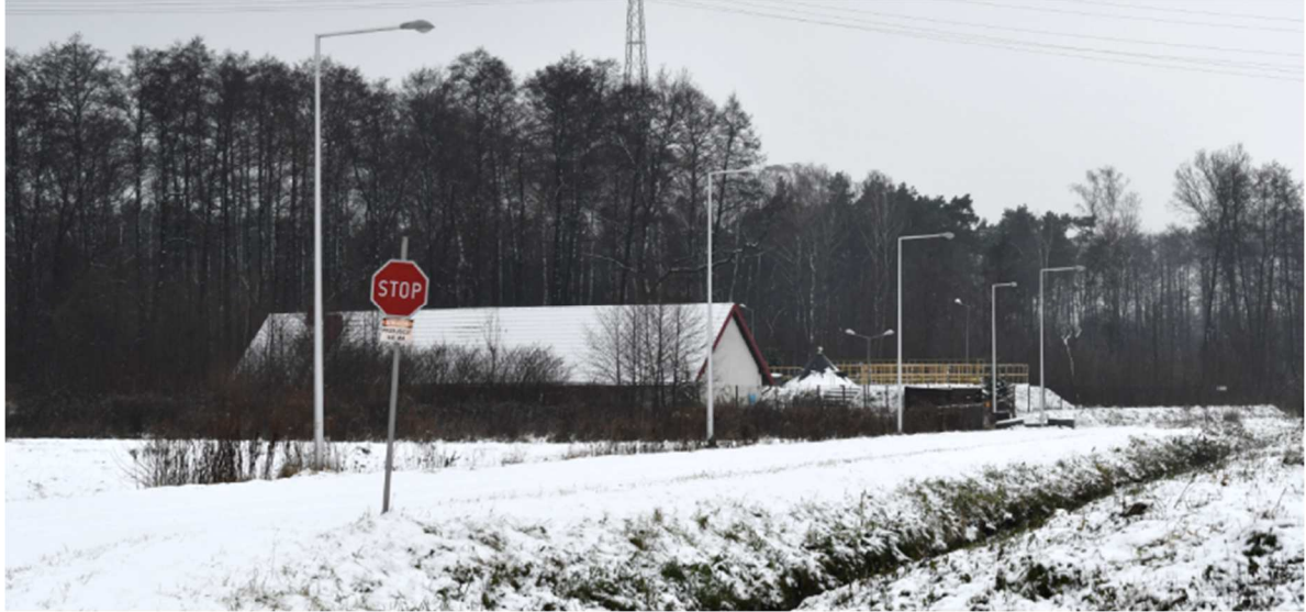
Oczyszczalnia ścieków w Wolicy
