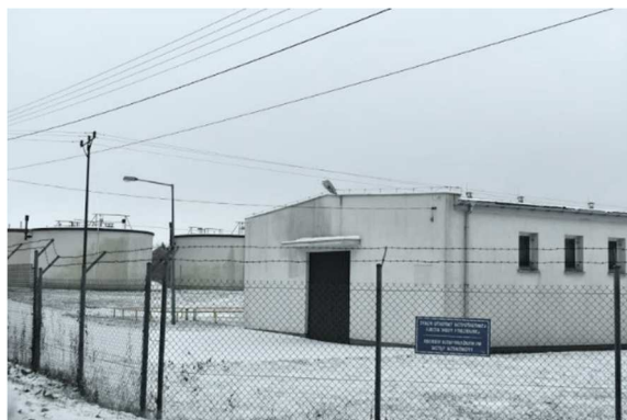
Ujęcie wody w Walendowie
