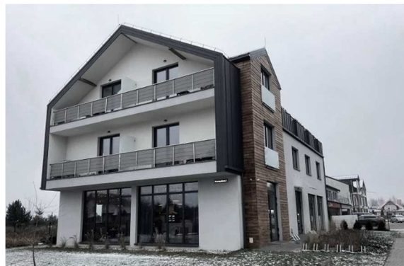
Zabudowa mieszkaniowa wielorodzinna w Rozalinie
